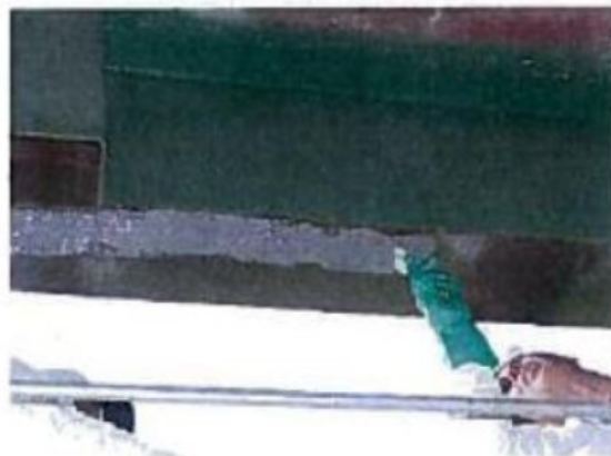
(d) Epoxy application on beam
