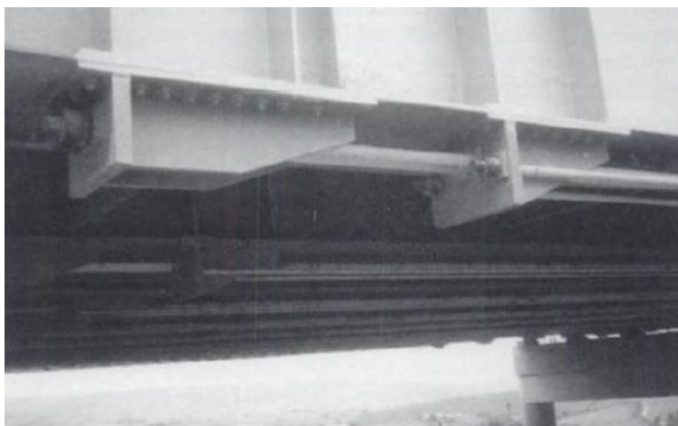
Příklad A2.1 - Zesílení za pomoci externího předpětí za pomoci ocelových přepínacích tyčí, Rakewood viadukt
