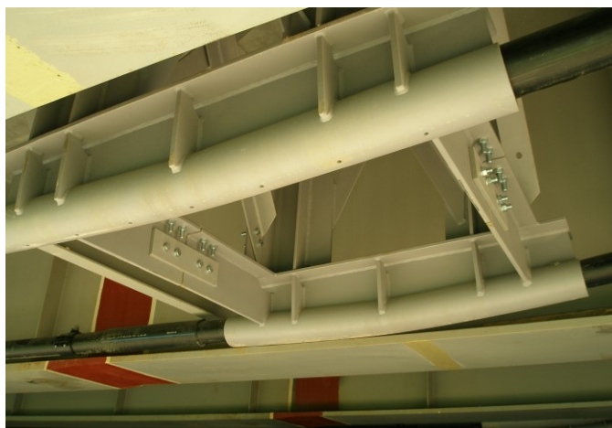
Příklad A2.2 – Zesílení ocelobetonové konstrukce za pomoci ocelových deviatorů, koncových železobetonových příčníků a externího předpětí
